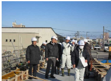
国道197号鶴崎拡幅道路改良事業
