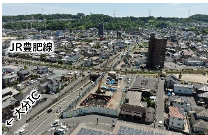
庄の原佐野線（下郡工区）整備状況
