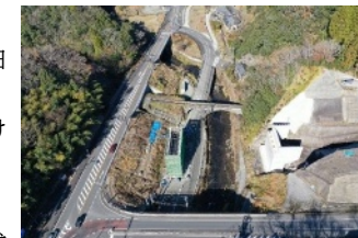
整備が進む中九州横断道路（竹田IC）
