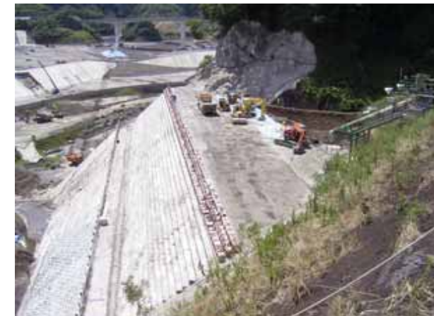
本体工区鞍部CSG施工状況
