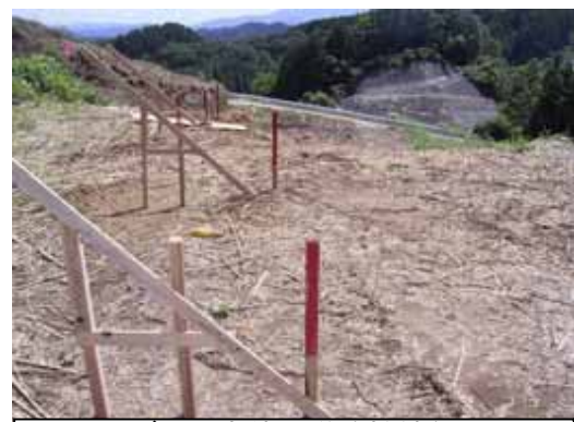
ダム工事外周道路接続部
