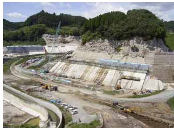
本体工区貯水池対策工状況
