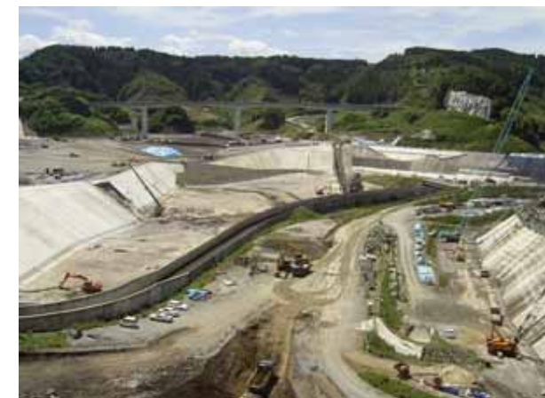
貯水池対策1工区状況
