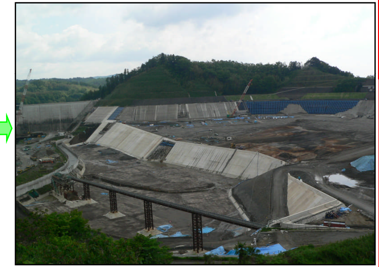
貯水池対策工事
