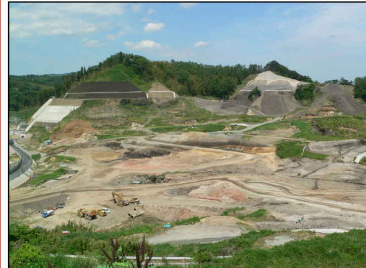
貯水池対策工事
