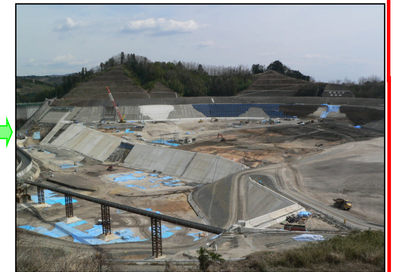
貯水池対策工事
