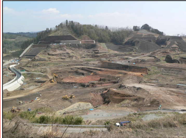
貯水池対策工事
