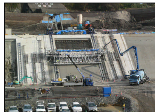
打設中盤の状況
