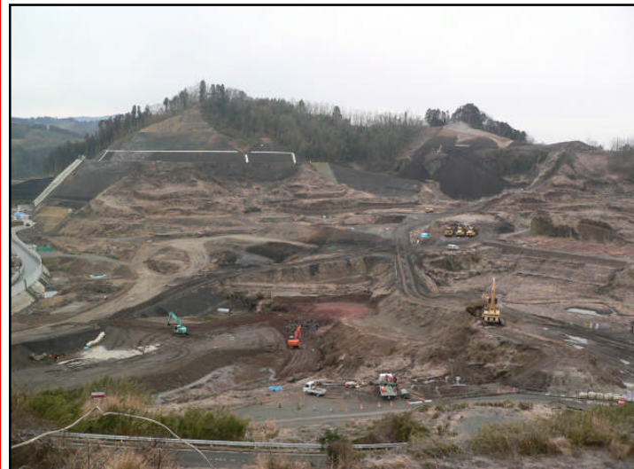
貯水池対策工事
