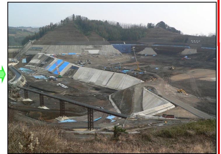
貯水池対策工事
