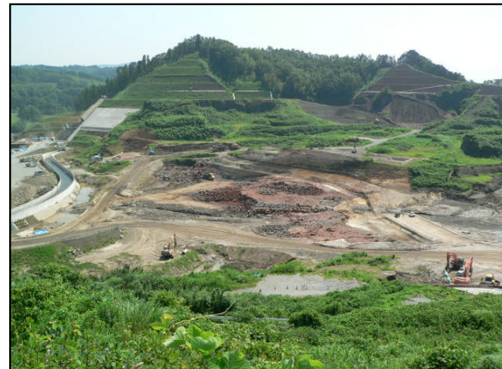
貯水池対策工事
