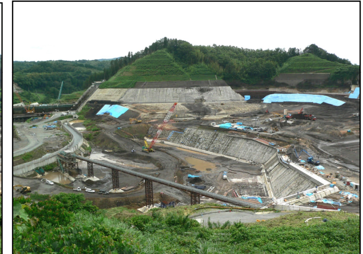
貯水池対策工事
