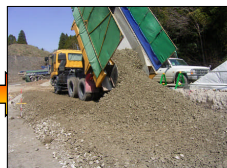
施工箇所までCSG材を運搬
