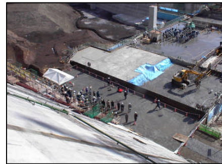
(10万 m^3 目のコンクリート打設を待)
