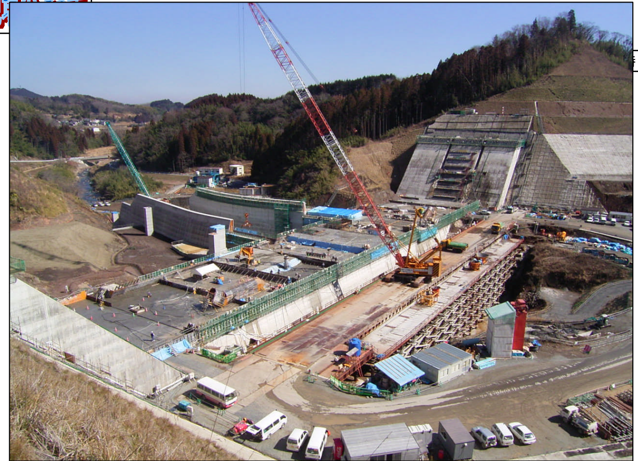
2月末時点で、堤体コンクリート全体数量約22万 m^3 のうち、11万 m^3 のコンク
