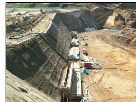
法面整形状況です。
