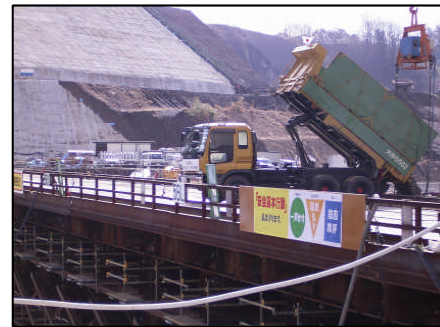
(打設量10万 m^3 目のコンクリートをコ)
