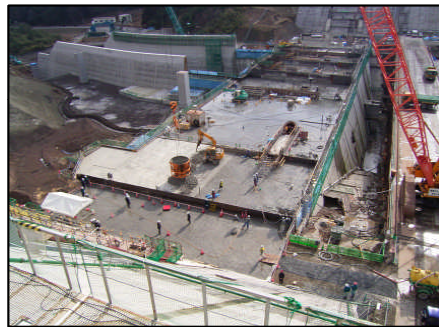
(当日、朝の通常のコンクリート打設)
