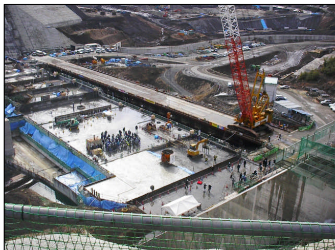
(コンクリートバケットをクレーンで打設場所まで)
