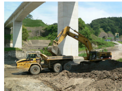
貯水池対策工事
