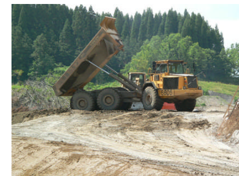
残土処理場工事(巣原地)
