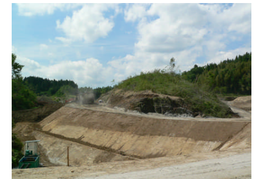
残土処理場工事(巣原地区)
