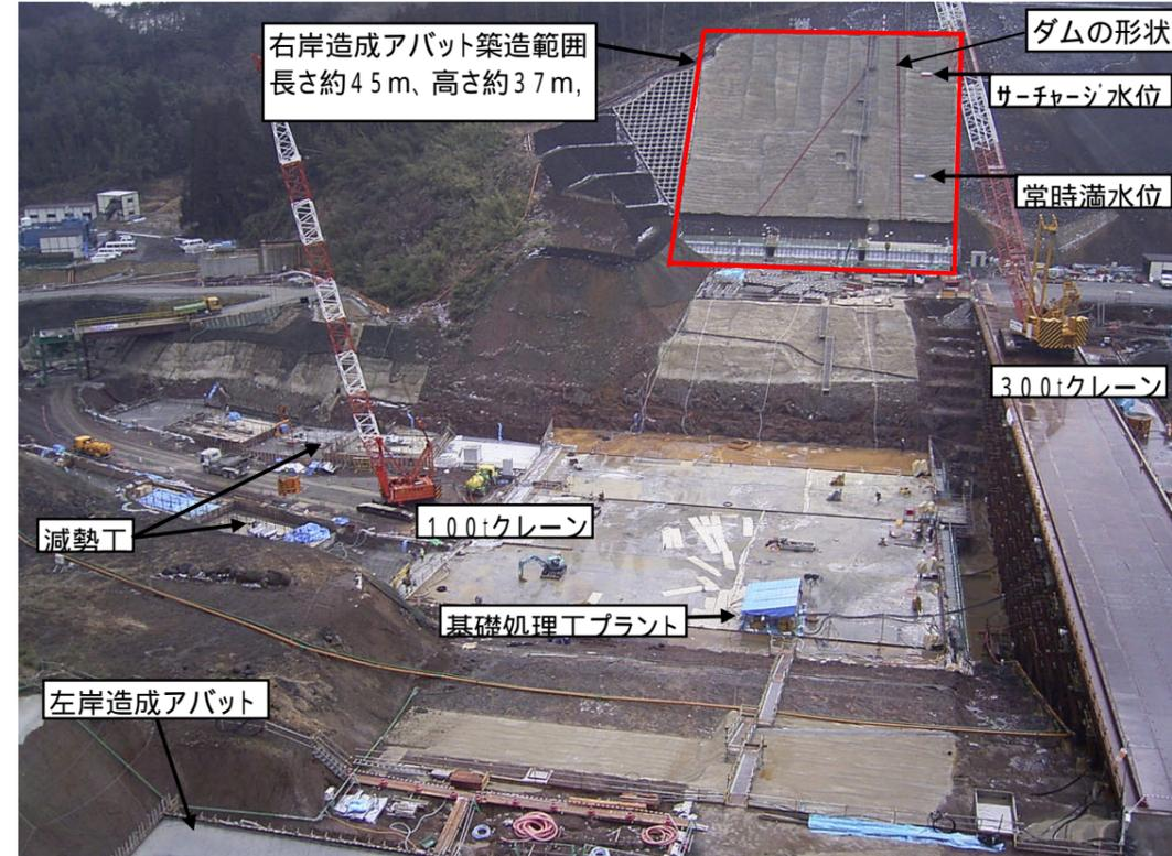
\* 減勢工では左側の100tクレーンを使用して打設します。
