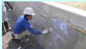
老朽化した水路壁のコーティング
