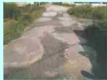
農道の窪みの補修
