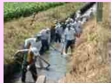
水路の泥上げ
