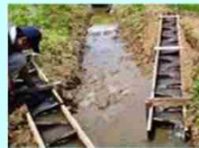
水田魚道の設置
