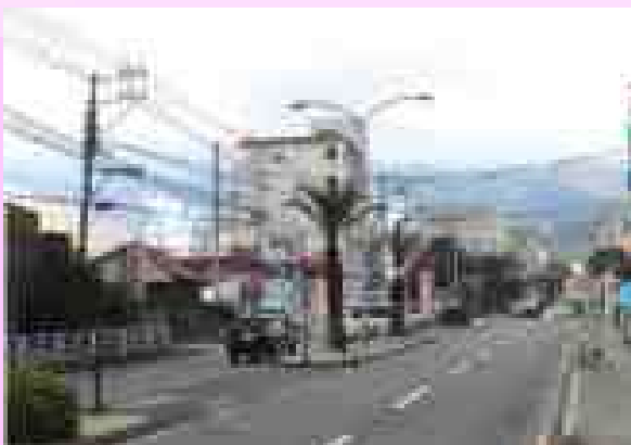
景観を損なう電線や電柱
