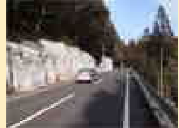
国道442号 合瀬工区（日田市）
