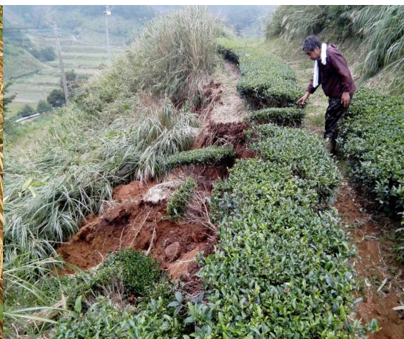
図2 大雨による法面の崩壊
