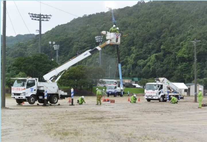
ライフライン復旧訓練
