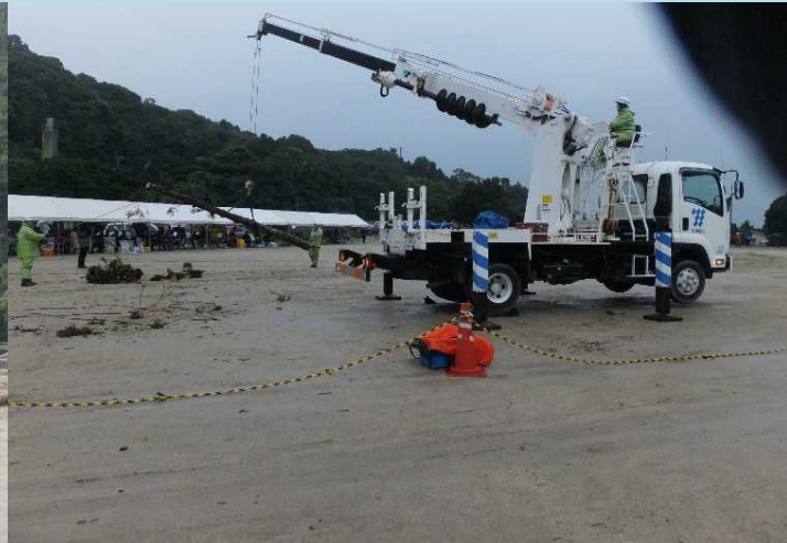
ライフライン復旧訓練
