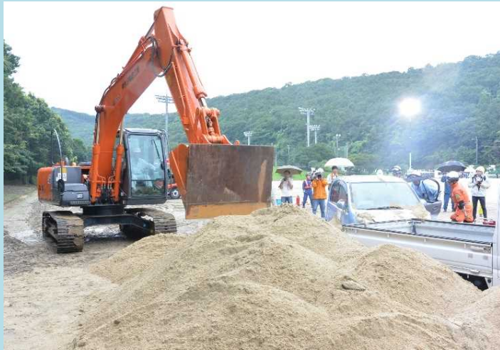
トンネル崩落救助救出訓練
