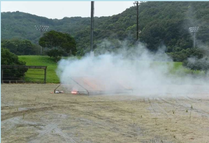
太陽光発電システム火災防ぎょ訓練
