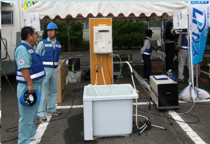
ライフライン復旧訓練
