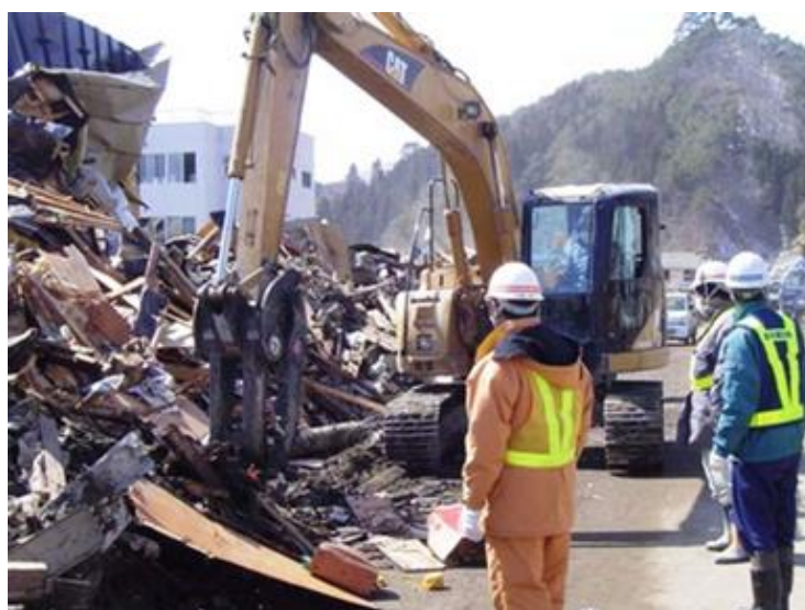
図13 岩手県宮古市における道路啓開状況
