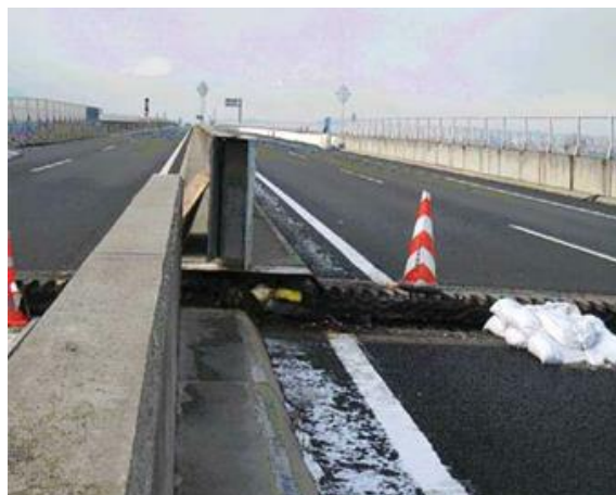
図 15 橋梁ジョイント部の土のうによる段差解消例
