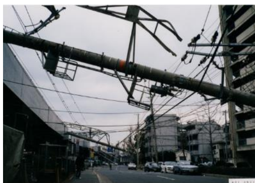
図 14 六甲道駅付近における電柱倒壊状況
