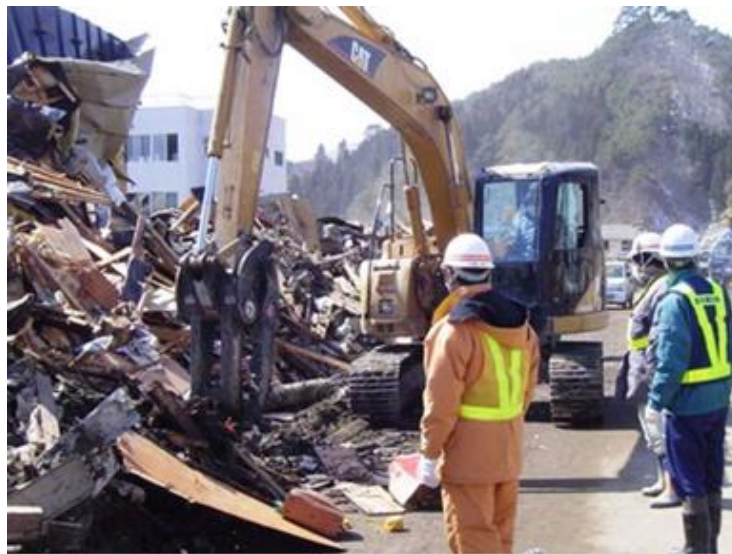
図 3.44 岩手県宮古市における道路啓開状況
