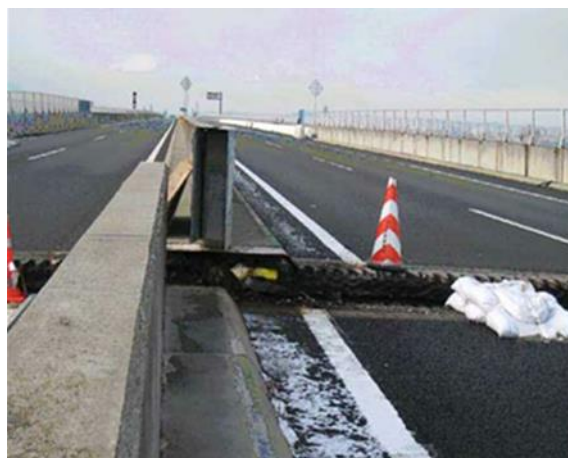
図 3.47 橋梁ジョイント部の土のうによる段差解消例
