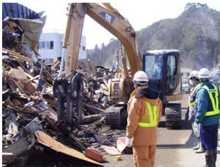
図 3.44 岩手県宮古市における道路啓開状況
