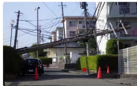
■熊本地震時の電柱倒壊例
