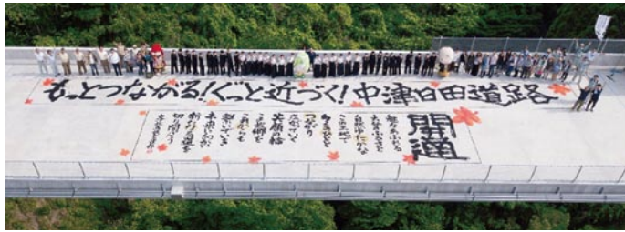
耶馬溪道路山移4号線の完成に併せ、地元高校生による書道パフォーマンスを実施
