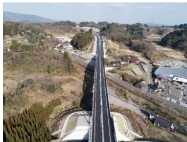
整備の進む 中九州横断道路 (大野竹田道路)
