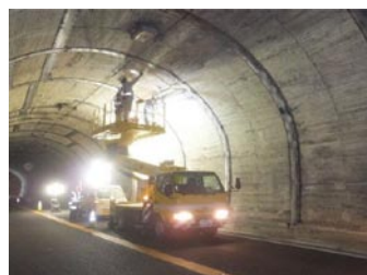
トンネルの定期点検
