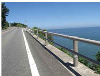
景観に配慮した防護柵に更新 (国道213号(豊後高田市)からの眺望)
