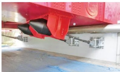
橋梁耐震化の事例
