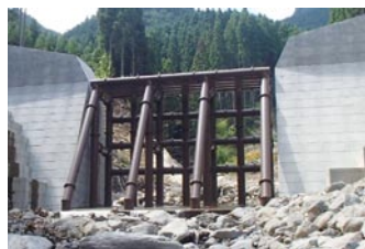
砂防えん堤工
