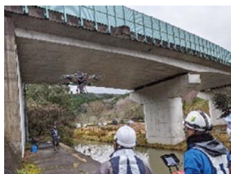
ドローンによる橋梁点検
