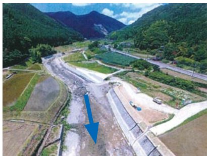
小野川完成状況（日田市）
