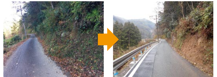
路肩拡幅による通行空間の確保
