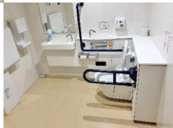
多目的トイレの設置 (県立総合文化センター) (大分市)
