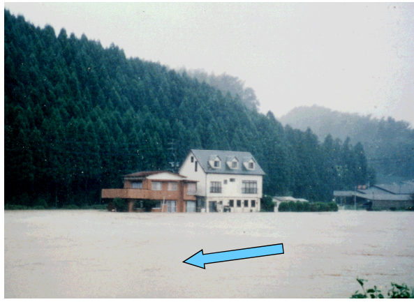
臼杵川浸水写真(H9年9月)
