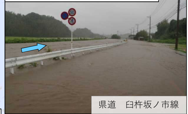
熊崎川 浸水状況 (H23.9)
