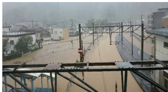
JR津久見駅付近(H29年10月)
