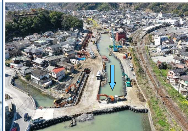
津久見川(整備中写真)
