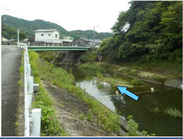
熊崎川(整備済区間)
