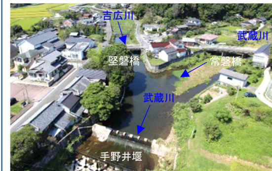
武蔵川(整備中状況写真)
