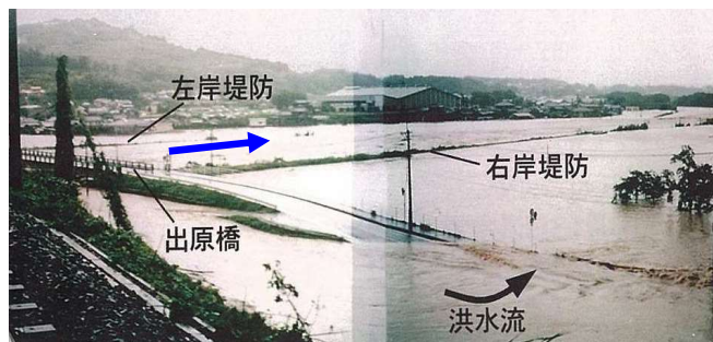
八坂川浸水写真(H9年9月)
