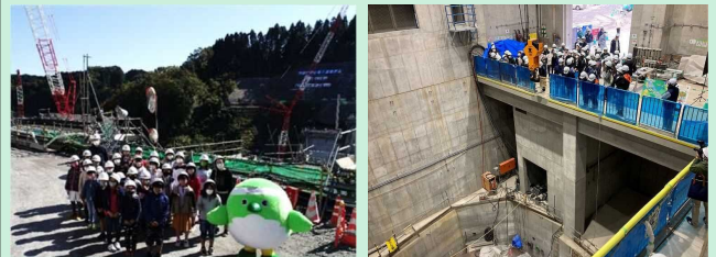
玉来ダム現場見学 (竹田市立豊岡小学校)
