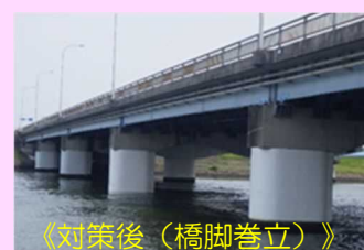
橋梁耐震化工事
