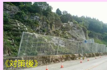
道路法面对策事例 国道502号（豊後大野市）
