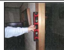
水平器による柱の傾きの計測
