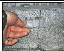
基礎のひび割れ幅の計測
