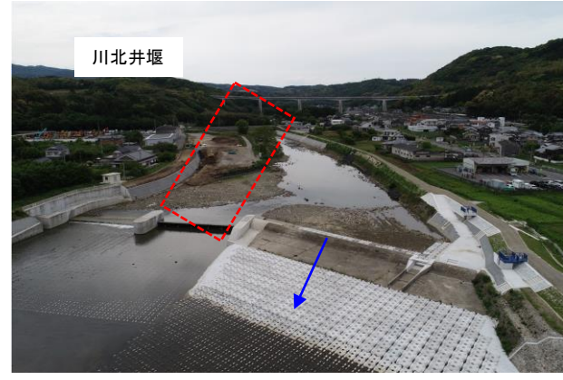
八坂川(整備中写真)
