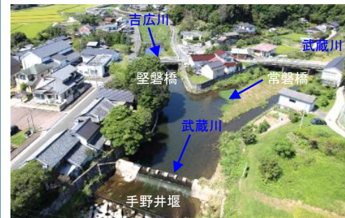
武蔵川(整備中状況写真)
