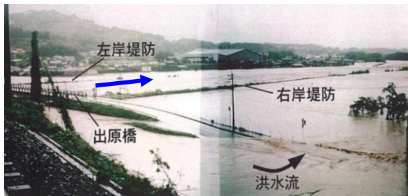
八坂川浸水写真(H9年9月)
