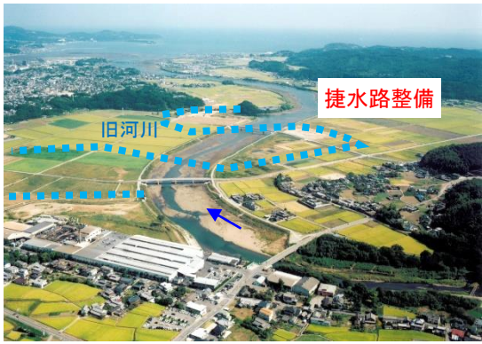
八坂川(整備済区間)
