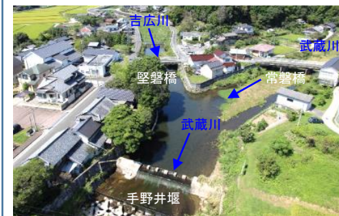
武蔵川(整備中状況写真)
