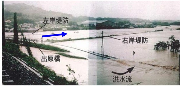
八坂川浸水写真(H9年9月)
