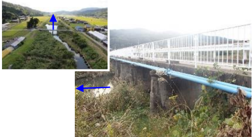
武蔵川(整備済区間)
