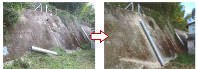
排水管の更新
