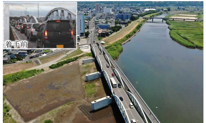
国道197号 (鶴崎拡幅) 進捗状況
