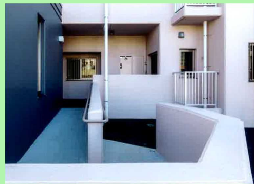
アプローチにスロープを設置
