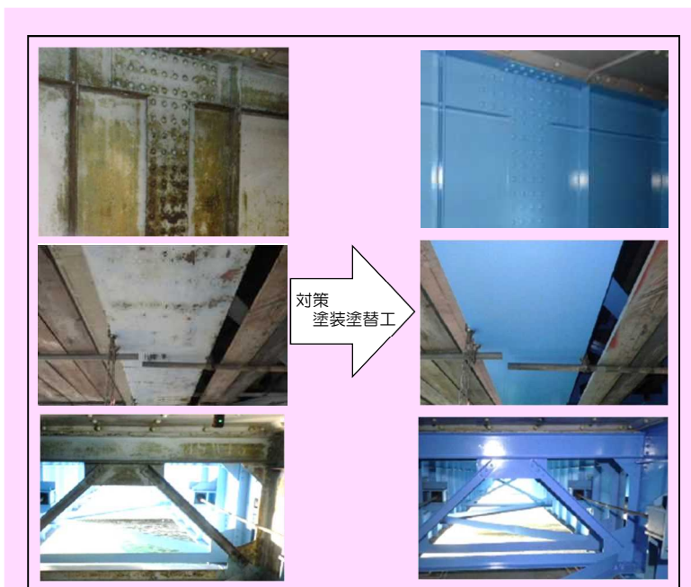
橋梁 大在大分港線 弁天大橋 (大分市)
