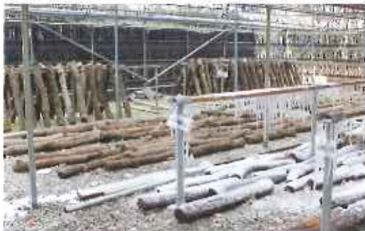
凍結散水の状況
