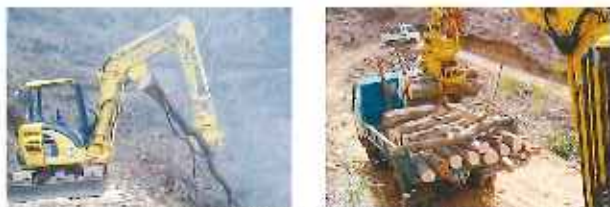
グラブ活用事例（左：原木搬出、右：積み込み）
