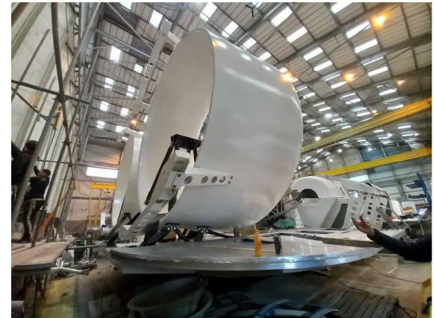
プロペラダクトと舵取り付け用基礎
