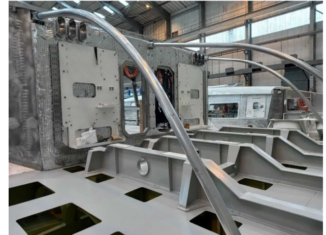
エンジン基礎と機関室
