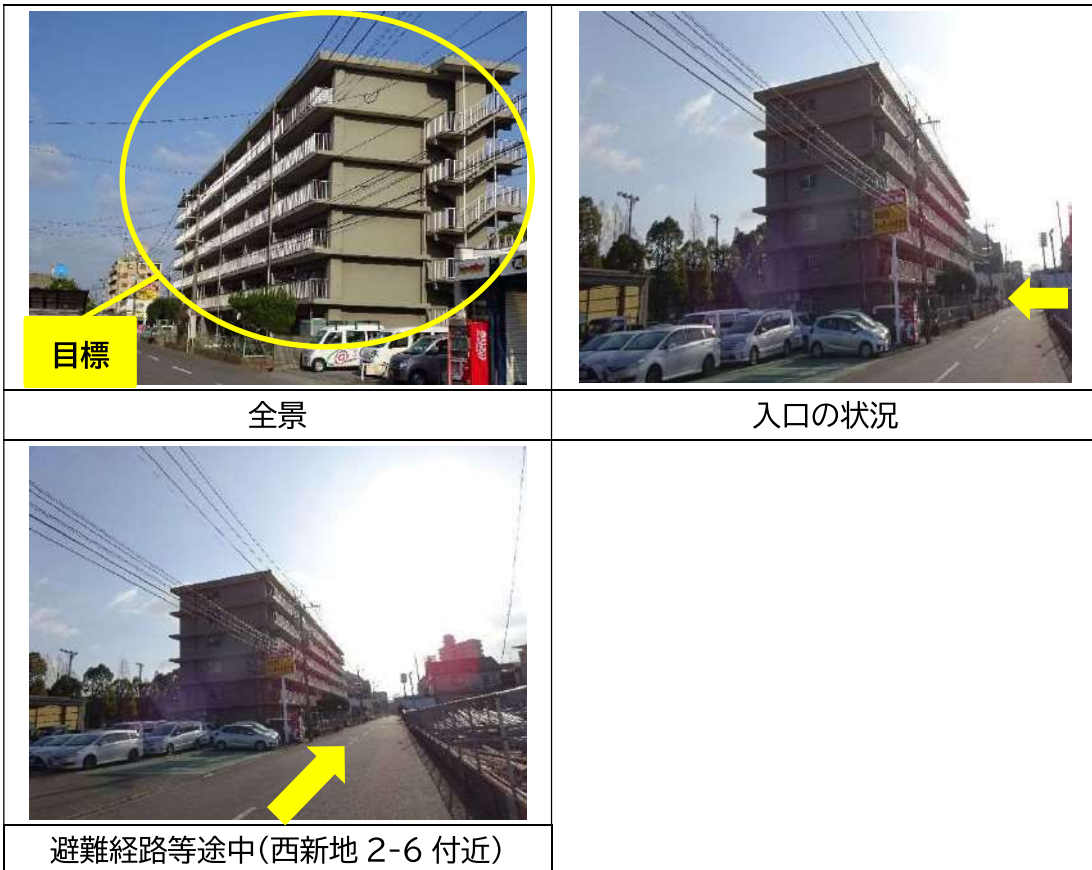
写真1 避難施設等の状況
