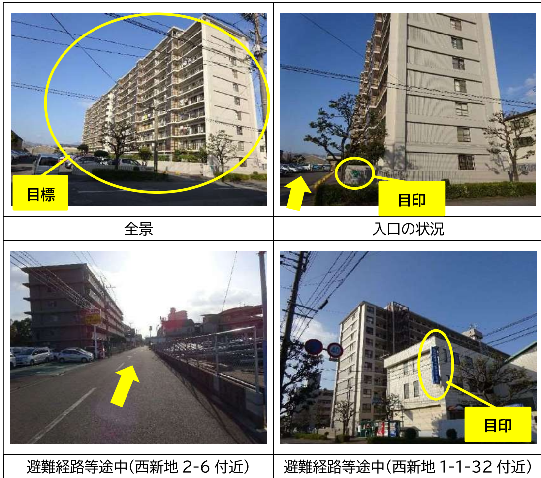
写真 2 避難施設等の状況
