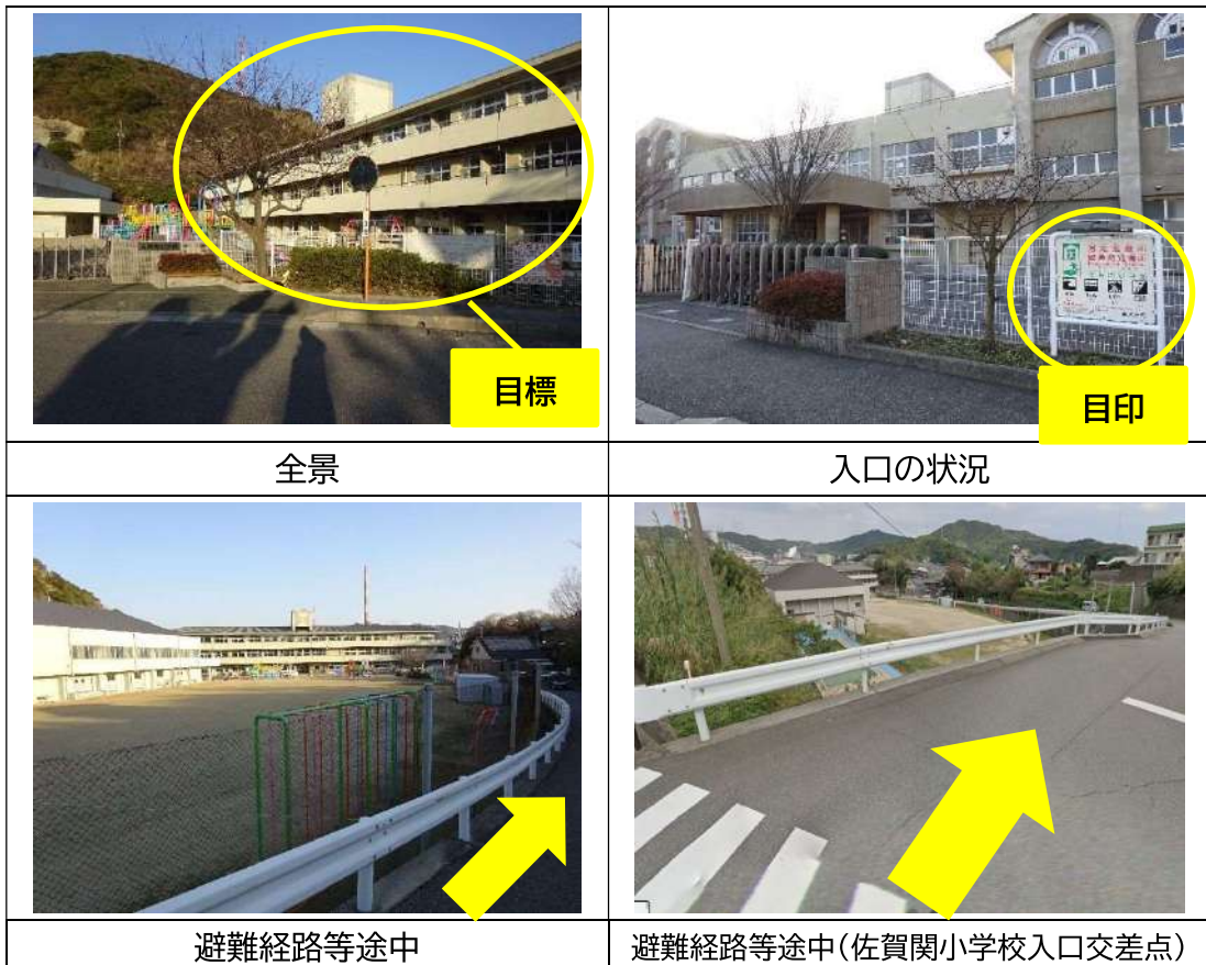
写真1 避難施設等の状況
