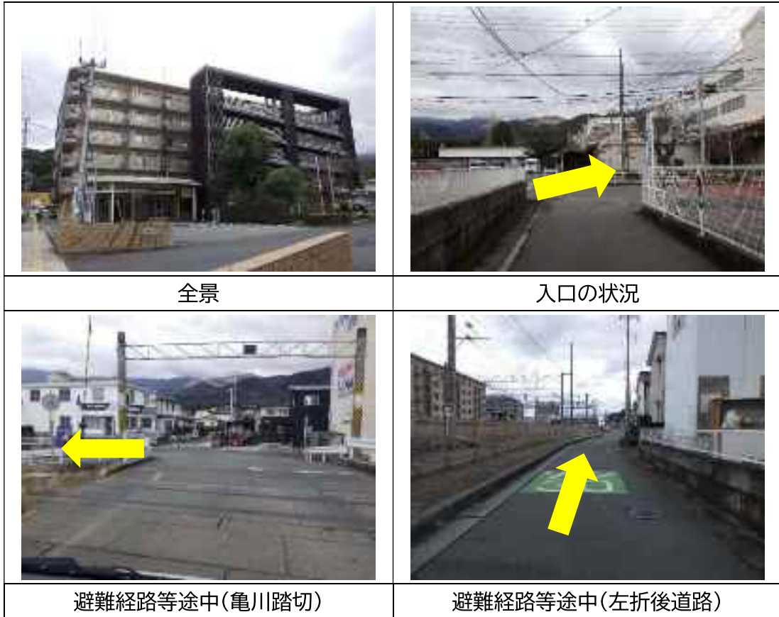
写真1 避難施設等の状況
