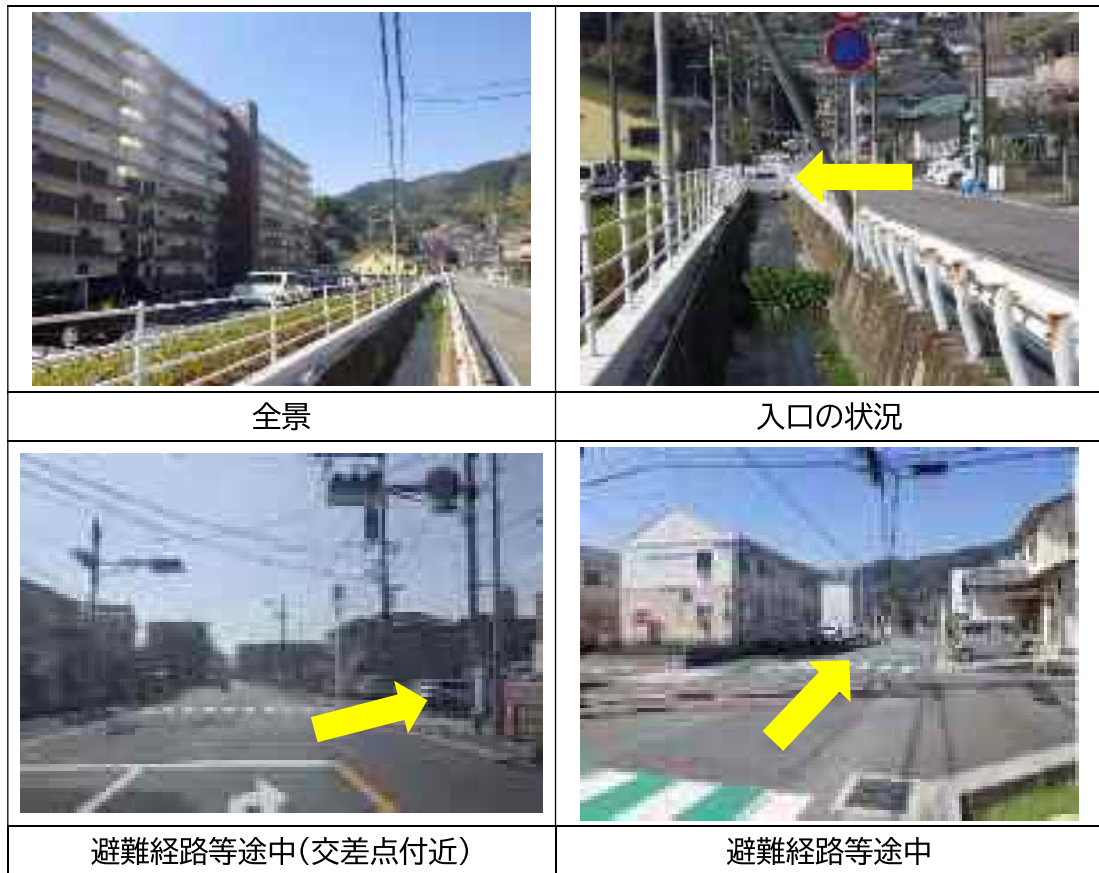
写真 5 避難施設等の状況
