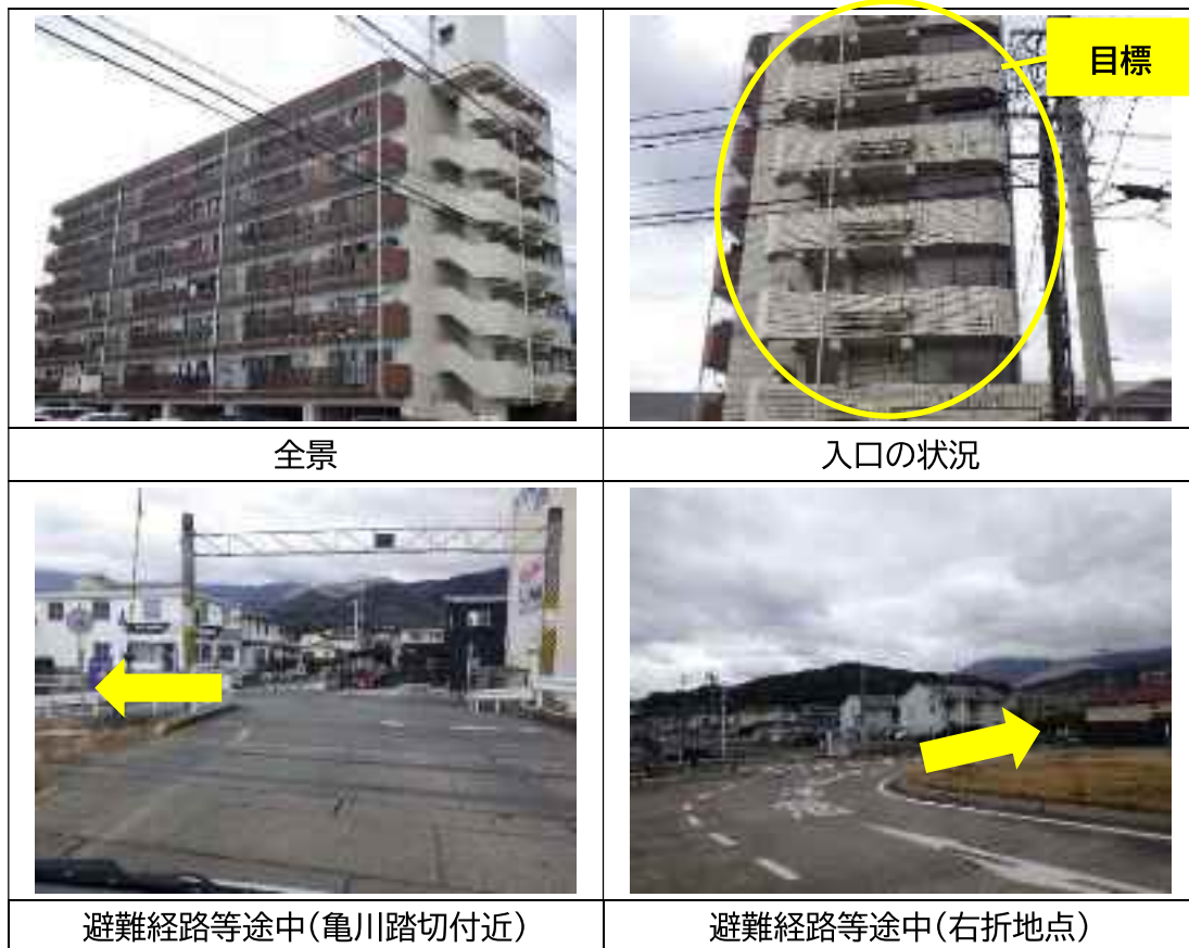
写真 2 避難施設等の状況
