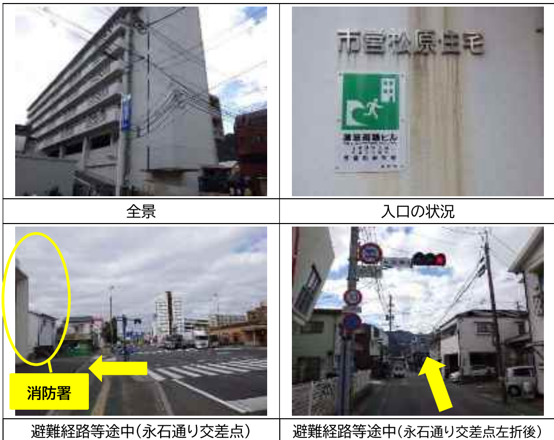
写真1 避難施設等の状況
