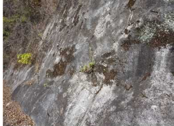
【モルタル・コンクリート吹付】
