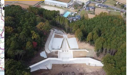
令和4年度の取組 砂防設備の整備
