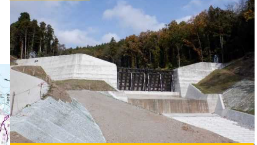
令和4年度の取組 砂防設備の整備
