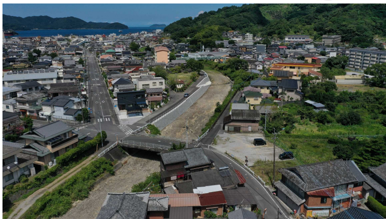
【中田橋下流付近】
