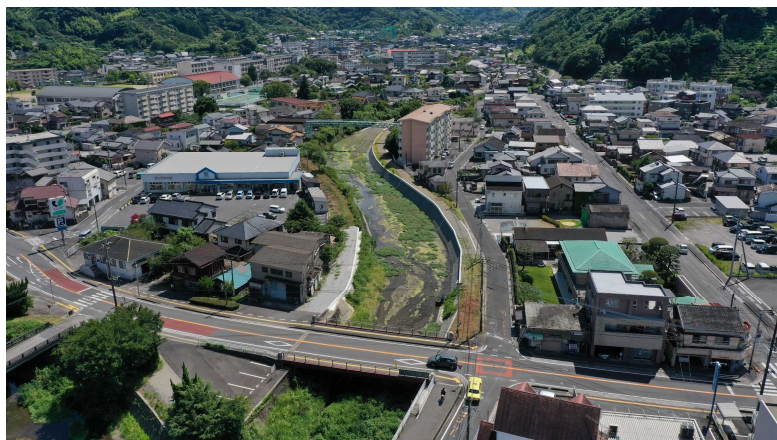
【八幡橋上流付近】
