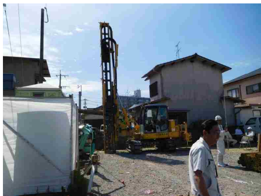
大分市佐野の住宅建築現場 実演会 木杭を地中に埋め込む工程を実演
