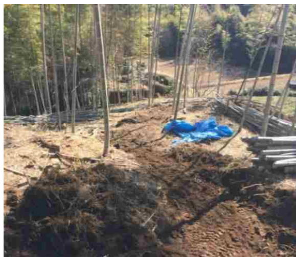
【簡易作業路の開設状況】
