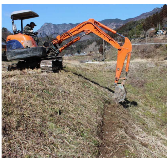
写真Ⅲ 3-1 パワーショベルによる作業道造成状況 (中津市耶馬溪町、2012年2月中下旬) 左：法面上方からの作業、右：法面下からの作業
