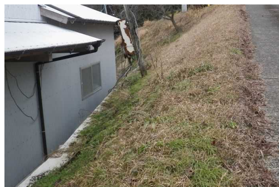
写真II 61-2 定植後約1年半が経過した法面 (冬期のため、地上部は枯れている)
