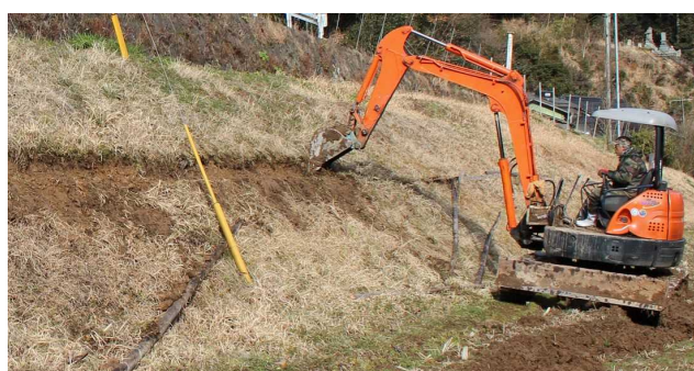
写真Ⅲ 3-1 パワーショベルによる作業道造成状況 (中津市耶馬溪町、2012年2月中下旬) 左：法面上方からの作業、右：法面下からの作業
