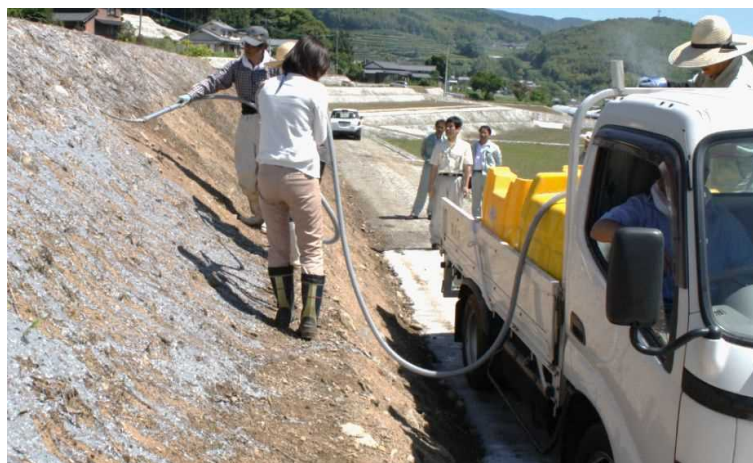
写真Ⅱ32-4 杵築市久保畑地区新設法面での吹付作業 (2013年6月12日)
