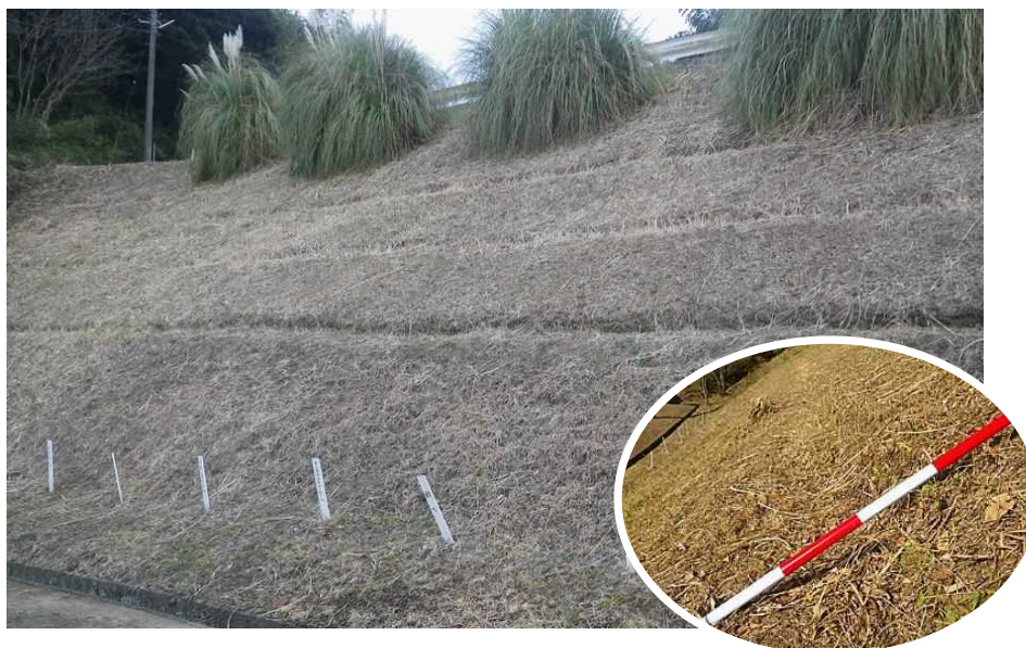
写真Ⅲ5-2 2011年5月に造成した作業道の状況(2015年2月12日撮影)
