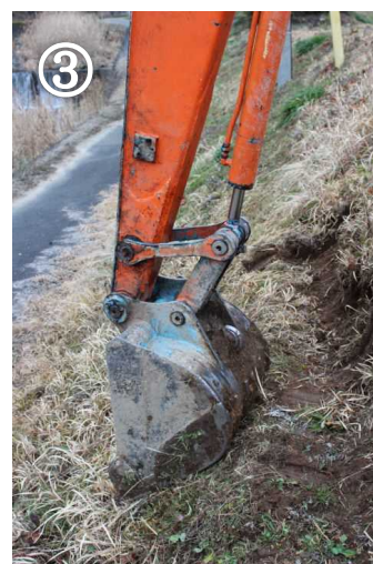
③ 造成した下側をバケットの背で押さええて整える。
