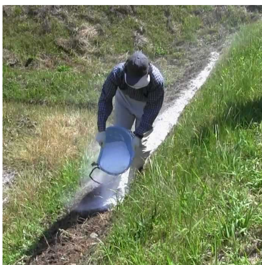
写真Ⅲ 22-5 消石灰の撒布作業
