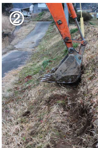
② 削った部分をバケットの背で押さえつける。
