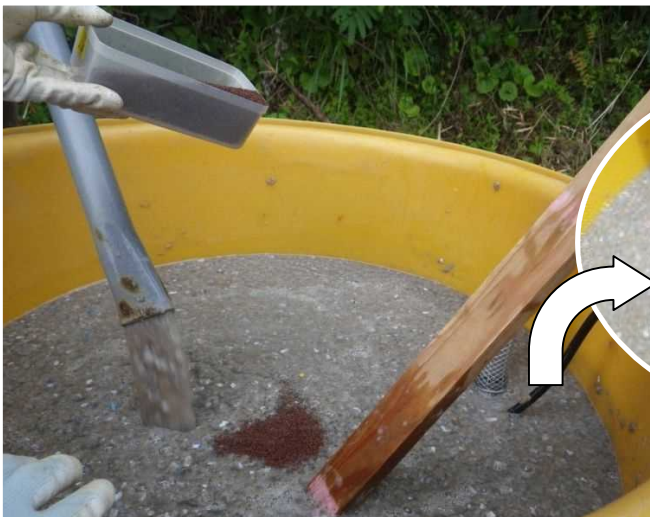
写真Ⅱ 32-3 センチピードグラス吹付播種資材の調製作業
