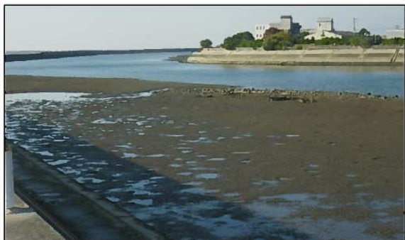
図2 豊後高田市呉崎地先 高田港導流堤内
