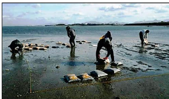
図2 碎石区の造成風景(碎石の散布)
