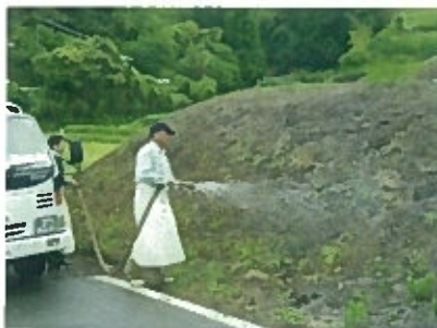
【種子吹き付け状況】
