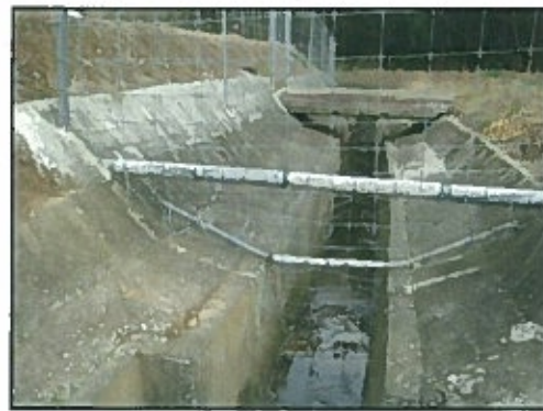
農業水路排水口の対応 (可動式の金網柵)
