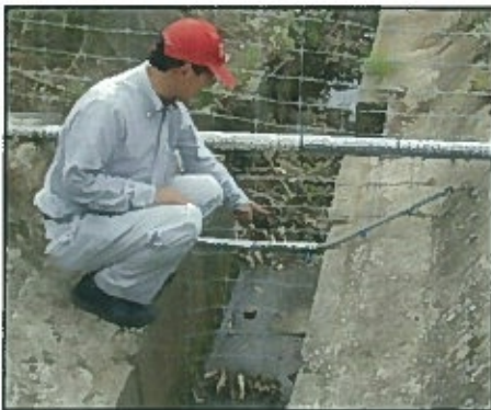
農業水路排水口の対応 (可動式の金網柵)
