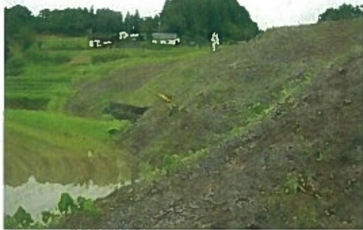
【6月15日吹き付け前】
