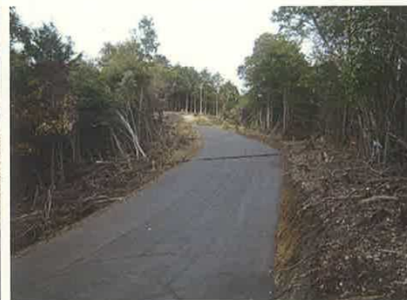
屋根迫線(宇佐市) 平成26年1月完成
