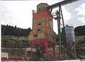
バッチャープラント
