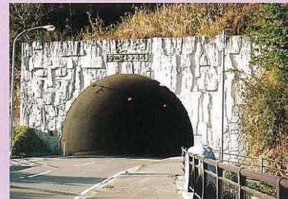
付替県道坑門
