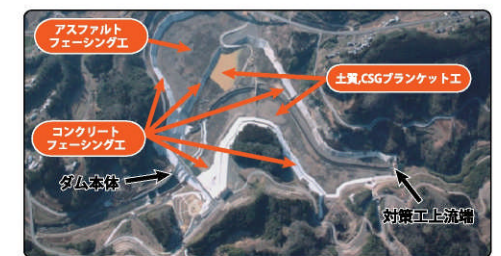
ダム及び貯水池表面遮水工全体施工完了
