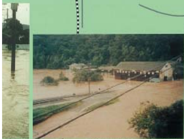
出水状況 平成9年9月16日 台風19号 出水状況
