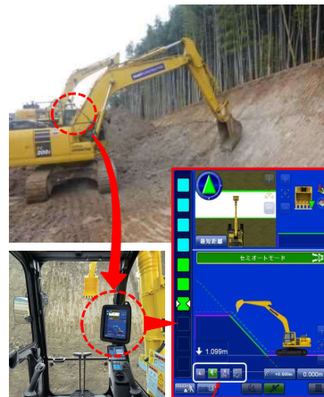
ICT建機での施工
