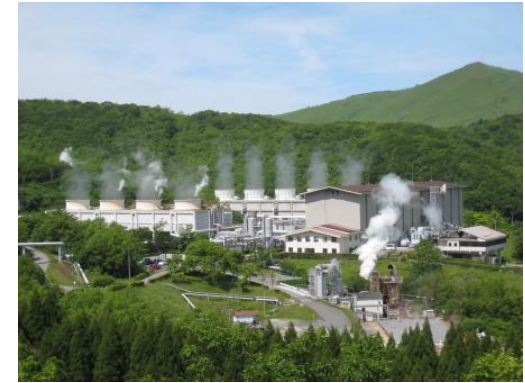
八丁原発電所(地熱)
