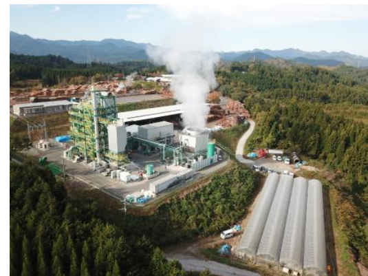
日本フォレスト(株)天瀬発電所(バイオマス)(日田市)
